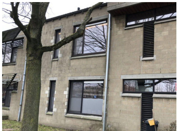
Detention House Kortrijk (Belgium)
